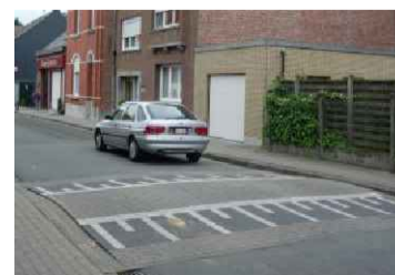
Drempel in betonsteen
