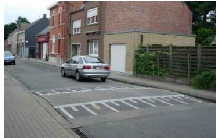
Drempel in betonsteen
