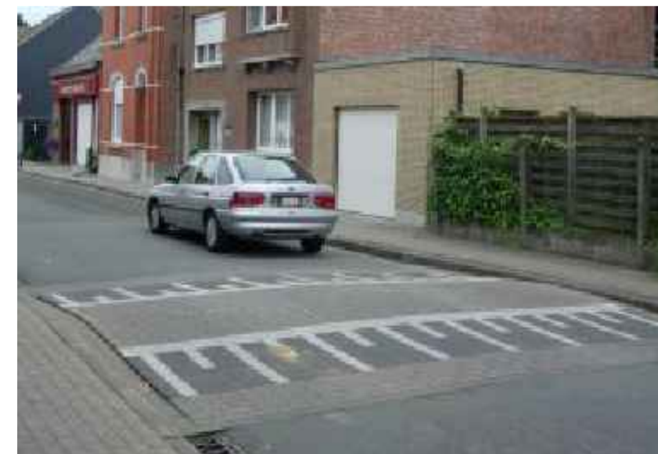
Drempel in betonsteen
