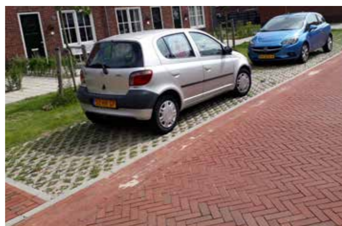
Referentiebeeld van gebouwd parkeren op maaiveld niveau en met parkeren op waterdoorlatende verharding.
